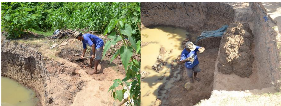
Fig. 1. Na imagem da esquerda pode se observar um carroceiro, utilizando uma pá para criar um degrau que o auxilia a se movimentar e movimentar a argila retirada da cova. Na imagem da direita, o degrau está construído e serve de apoio para a deposição de argila retirada do fundo da cova.
